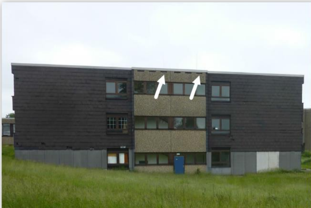
Abb. 2: Lage der bei der Fledermausuntersuchung zum B-Plan 18 „Lindrehm Süd“ in Kaltenkirchen 2014 ermittelten Zugänge des Breitflügelfledermausquartiers an der Süd-West Fassade des ehemaligen Klinikums.
